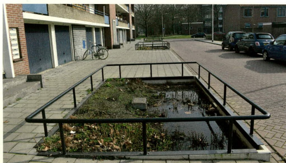
Full scale testen in Tilburg (links) en Arnhem (rechts) aan diverse regentuinten in 1 straat.
